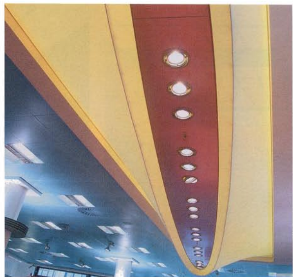
Spannfolien bieten die Möglichkeit, hinterleuchtete Freiformflächen einzuplanen. Im Medienkaufhaus Hugendubel in Berlin (Entwurf: Stöter, Tillmann, Kaiser) entstanden auf diese Weise dreidimensionale Leuchtkörper mit Farbwechseln. Für die Grundbeleuchtung sorgen Halogenleuchten.
