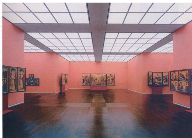
Im Wallraf-Richartz-Museum in Köln (Entwurf: O. M. Ungers) wurden 2500 Quadratmeter hinterleuchtete Glasdecken installiert. Die Fugentoleranz liegt unter einem Millimeter.
