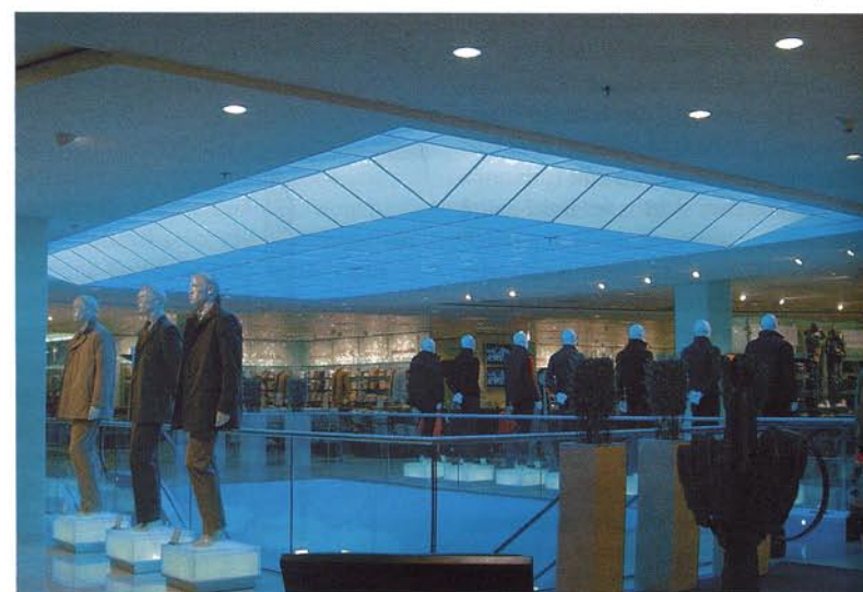
Diffusoren aus Acrylglas (hier im Modehaus Sinn Leffers) sind leichter als Glas, aber weniger kratzresistent. Zudem besteht die Gefahr des Verstaubens durch elektrostatische Aufladung.
