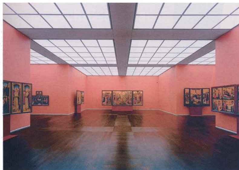
Im Wallraf-Richartz-Museum in Köln (Entwurf: O. M. Ungers) wurden 2500 Quadratmeter hinterleuchtete Glasdecken installiert. Die Fugentoleranz liegt unter einem Millimeter.
